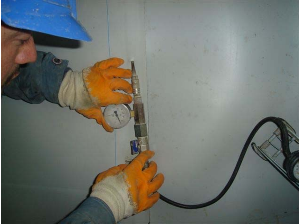
Foto 4. Geomembranlar üzerinde teşkil edilen iki kaynak arası arasında bir boşluk bırakılır ve orada basınçlı bir hava verilip herhangi bir kaçak olup olmadığı basınç manometresi ile kontrol edilir. Manometrede bir basınç değişimi olduğu takdirde kaynak işleminin uygun olmadığı kararı verilir ve geomembran kaynakları yeniden yapılır.
