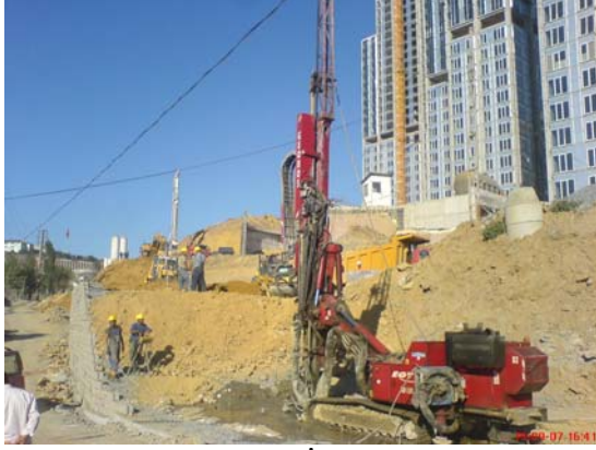
Şekil 7. Jet-Grouting İmalat Görüntüsü
