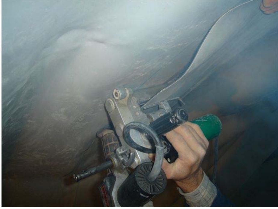
Foto 3. Geomembranları birbirine birleştirmek için kullanılan kaynak makinası
