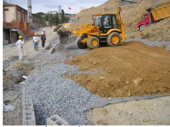
Şekil 8. GDİ Duvar İmalat Görüntüsü
