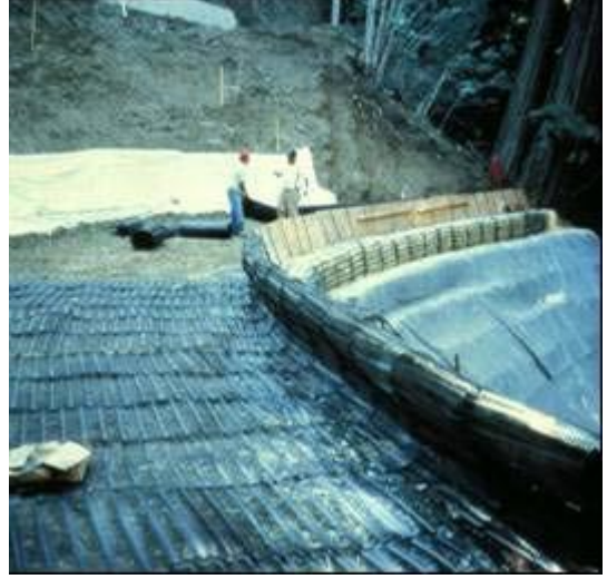
Donatılı dolgu yapısı ile iyileştirilmiş şev
