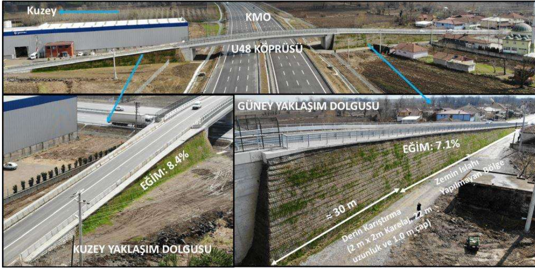
Şekil 8. KMO U48 Köprüsü, İnşaat Sonrası
