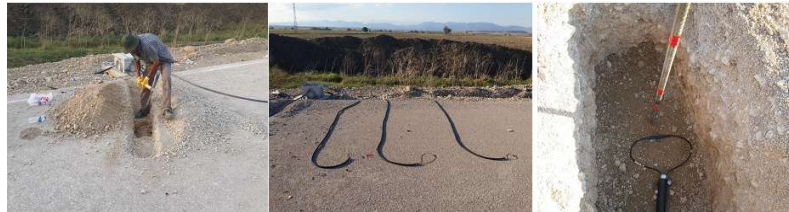
Şekil 8. Sıcaklık sensörlerinin montaj işlemlerinin yapılması
