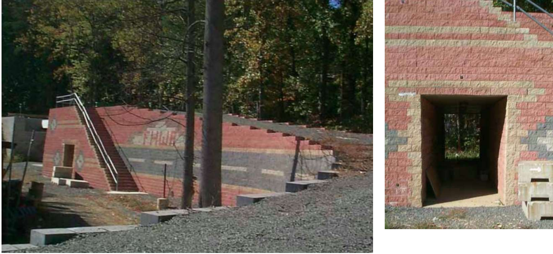
Şekil 8. Geosentetik Donatılı Menfez ve yakın görünüm (Adams ve diğ., 2011)
