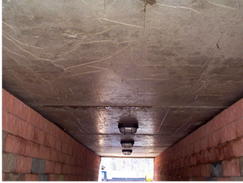
Şekil 10. Geosentetik donatılı menfez yapısı iç görünümü (Adams ve diğ., 2011)
