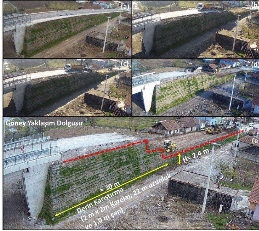
Şekil 10. KMO U48 Köprüsü Güney Geoarme Yaklaşım Dolgusunun Kontrollü Olarak Kazılması (a) Kazı Öncesi (b-d) Kontrollü Kazı İşlemi (e) Kazı İşleminin Tamamlanması
