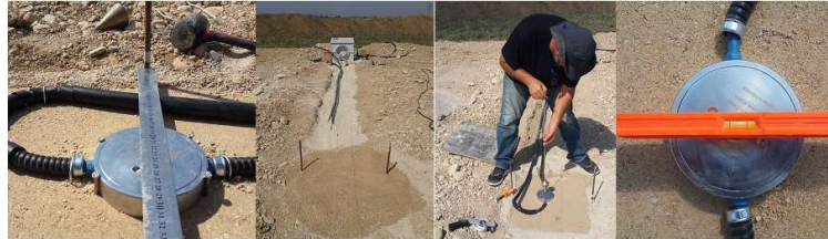
Şekil 4. Toprak basıncı sensörleri (Sensör Yüzeyi: Taban Zemin - 10mm)
