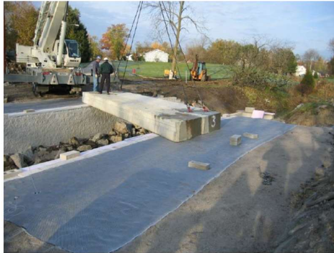
Şekil 5. Prekast döşeme/kirişin taşıyıcı yatak üzerine yerleştirilmesi (FHWA-HRT-17-080, 2018)
