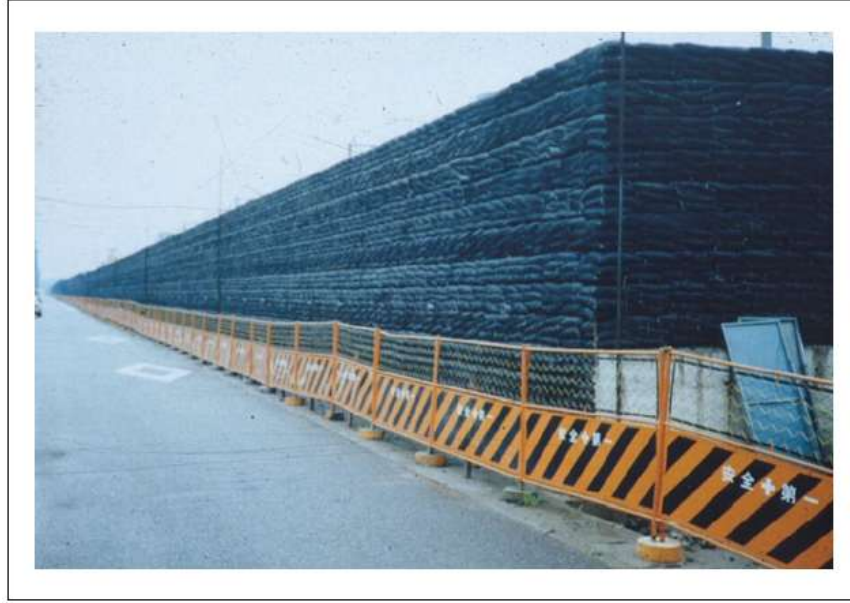
Şekil 3. Yerinde dökme perde öncesi bitmiş geosentetik donatılı dolgu (Tatsuoka, 2008)
