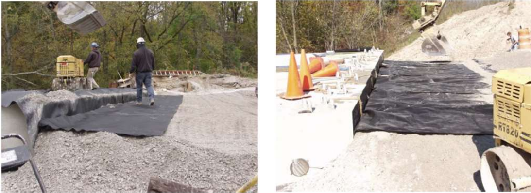
Şekil 7. Prekast döşeme/kiriş arkasında bohçalama entegre yaklaşım tabakası oluşturulması(FHWA-HRT-17-080, 2018)
