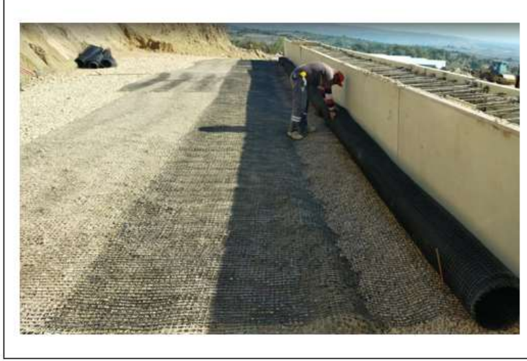
Şekil 6. Geogridlerin serilmesi
