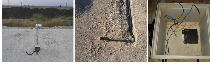
Şekil 6. Yatay deplasman sensörlerine ait çelik tellerin geçeceği kanalların montajlarının yapılması ve çelik telin yüzeye sabitlenmesi
